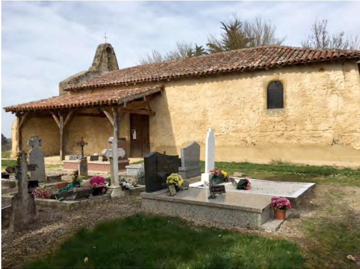
Un coup de vent avait endommagé le mur extérieur de la Chapelle. Grâce à l'indemnisation de l'assurance nous avons réussi à réparer et faire quelques travaux. Nous avons enlevé le trottoir béton qui empêchait les murs en terre de respirer. Nous avons fait recrépir le bas des murs extérieurs et nous avons fait réparer les murs intérieurs en plâtre. Les vieilles haies ont été arrachées et nous replanterons à l'automne une charmille qui clôturera le cimetière.
